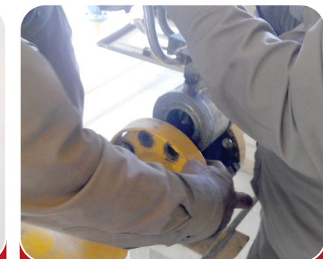
۱- باز کردن رگولاتور از مدار
