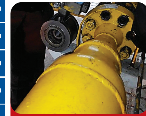
۴- قراردادن رگولاتور در مدار
